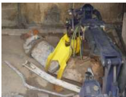
Рис.9. Сортировка высокоактивных отходов робототехническими средствами «Brokk».
