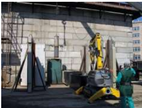
Рис. 6. Упаковка пеналов в транспортные контейнеры с помощью ДУМ «Brokk-330».
