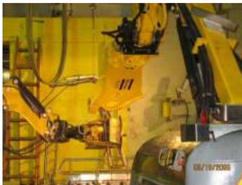
Рис. 11. Отделение элементов петлевых каналов с помощью дистанционно управляемых робототехнических механизмов «Brokk-180» и «Brokk-330»
