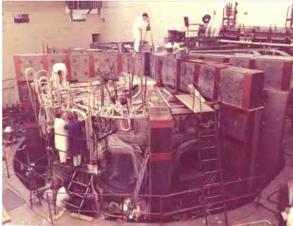
Рисунок 1.9 - Монтаж 12-ти яремного магнитопровода
