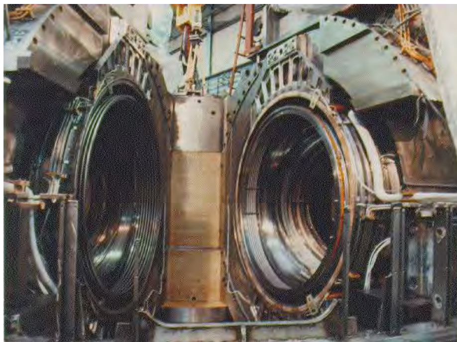
Рисунок 1.6 - Сборочные модули и опорная колонна на штатном месте
