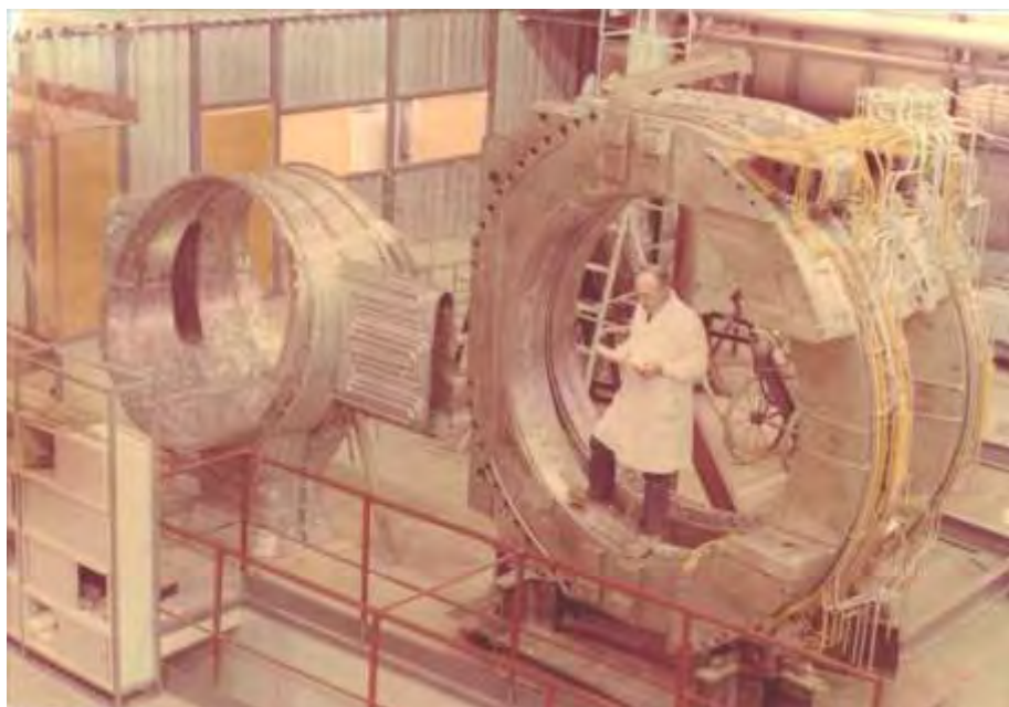
Рисунок 1.5 - Монтажный блок и 1/12 секция внутреннего азотного экрана
