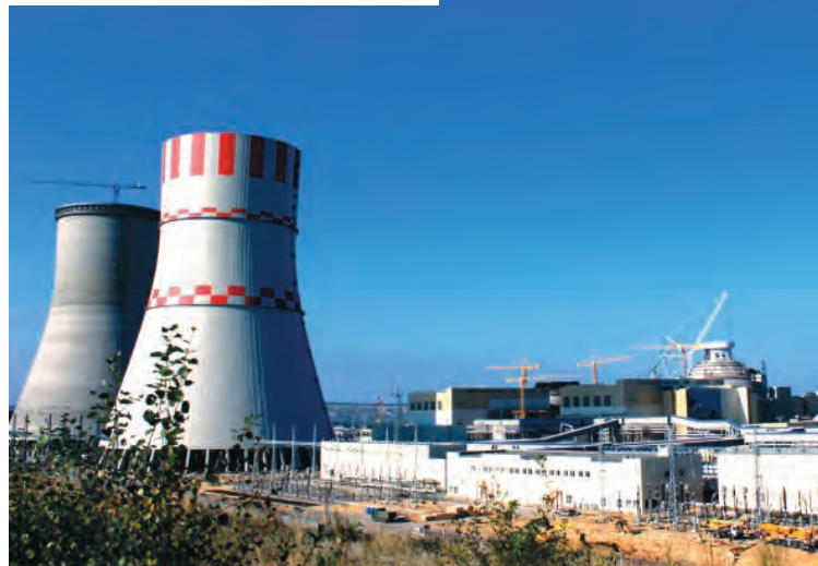
АЭС на стадии строительства
