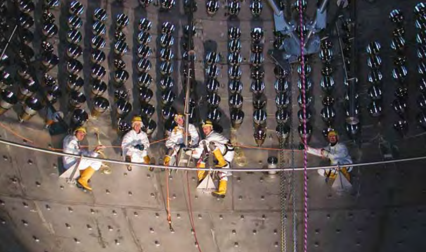
Монтаж ФЭУ детектора Борексина
