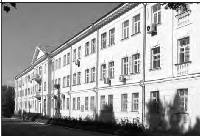
Здание Лаборатории № 2 (Главное здание)
