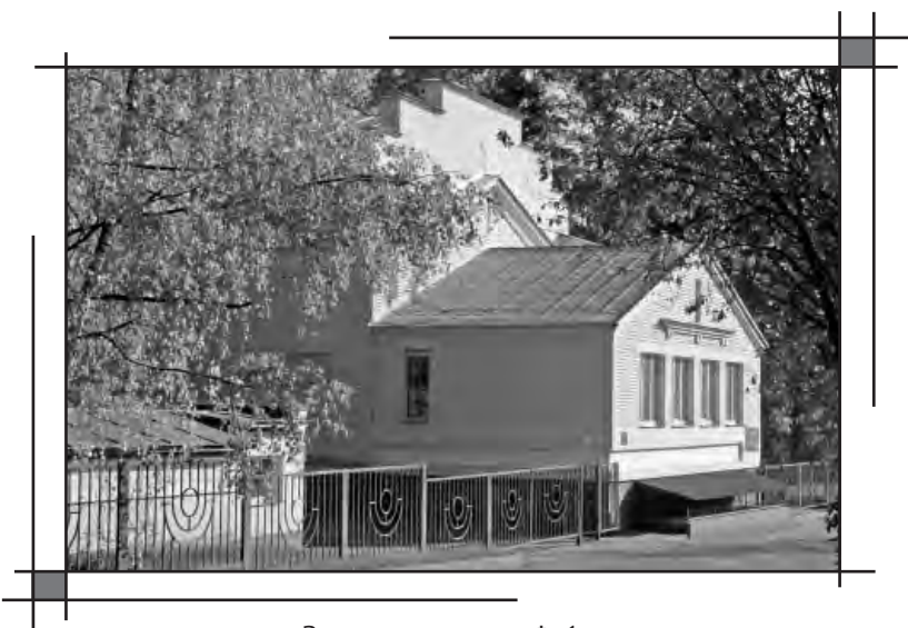
Здание реактора Ф-1
