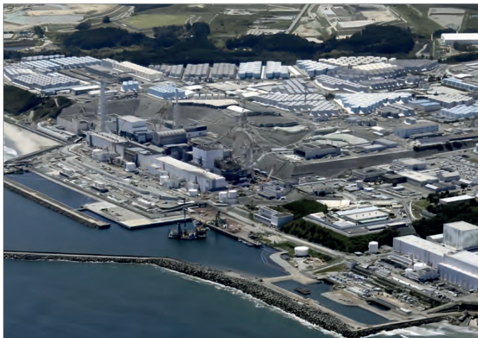
Рис. 30. F-1 в последнее утро перед началом сброса воды в океан — 23 августа 2023 года
