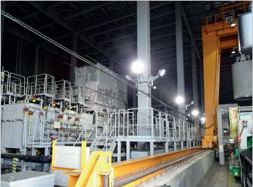
Рис. 9. Внутри здания, в котором размещается ALPS
