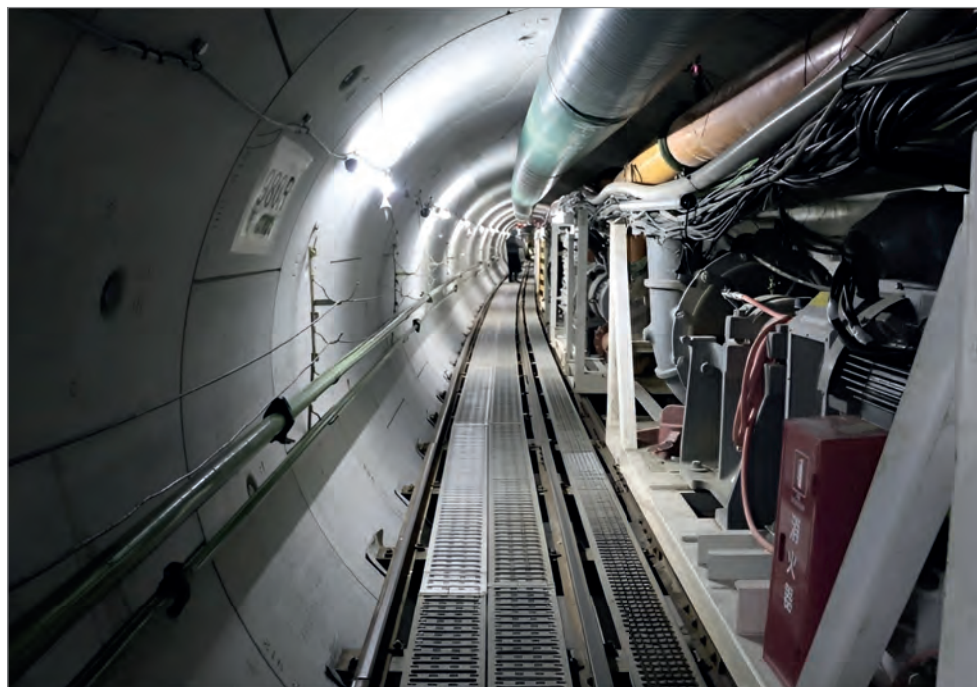
Рис. 1. Тоннель, по которому происходит слив воды
