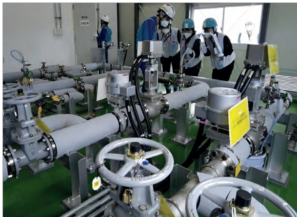
Рис. 18. Монтаж аварийного клапана системы сброса
