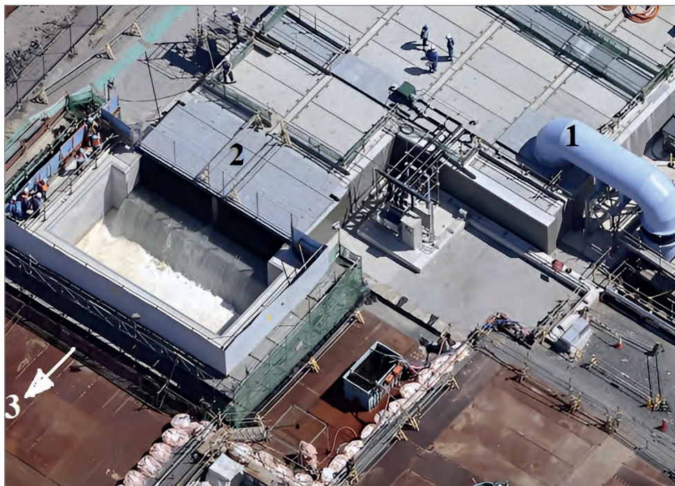
Рис. 3. 24 августа 2023 года работавшие на F-1 наблюдали за началом сброса воды в океан. 1 – труба с морской водой, 2 – бассейн хранения, 3 – направление сброса
