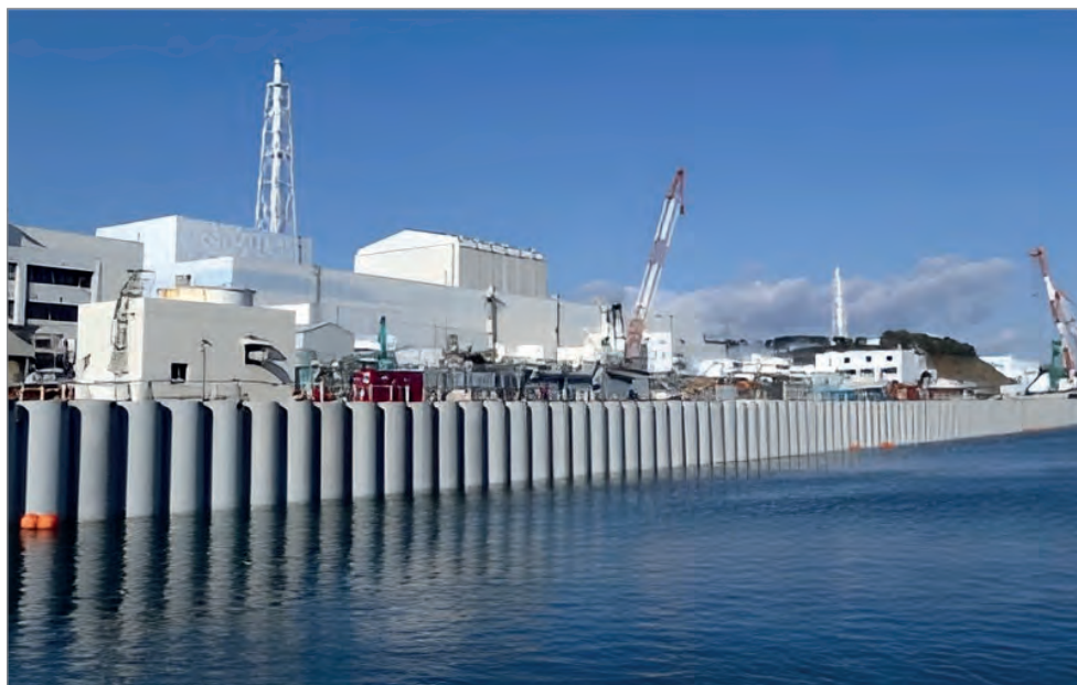
Рис. 5. «Защитная стена», ограничивающая поступление радиоактивной воды в океан
