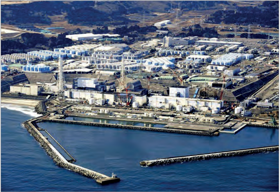
Рис. 12. По состоянию на 31 июля 2023 года на территории F-1 было 1073 баков, объем их превысил \sim 1,3 \times 10^6 \text{ м}^3
