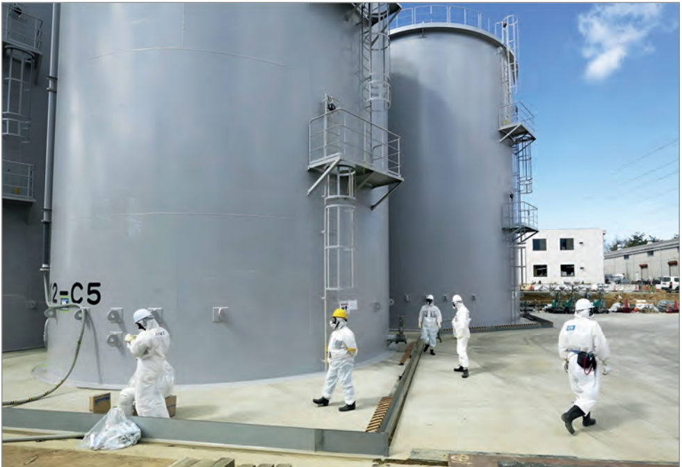
Рис. 13. Типовые (сварные, гораздо более прочные, чем предыдущие модели) баки на территории F-1
