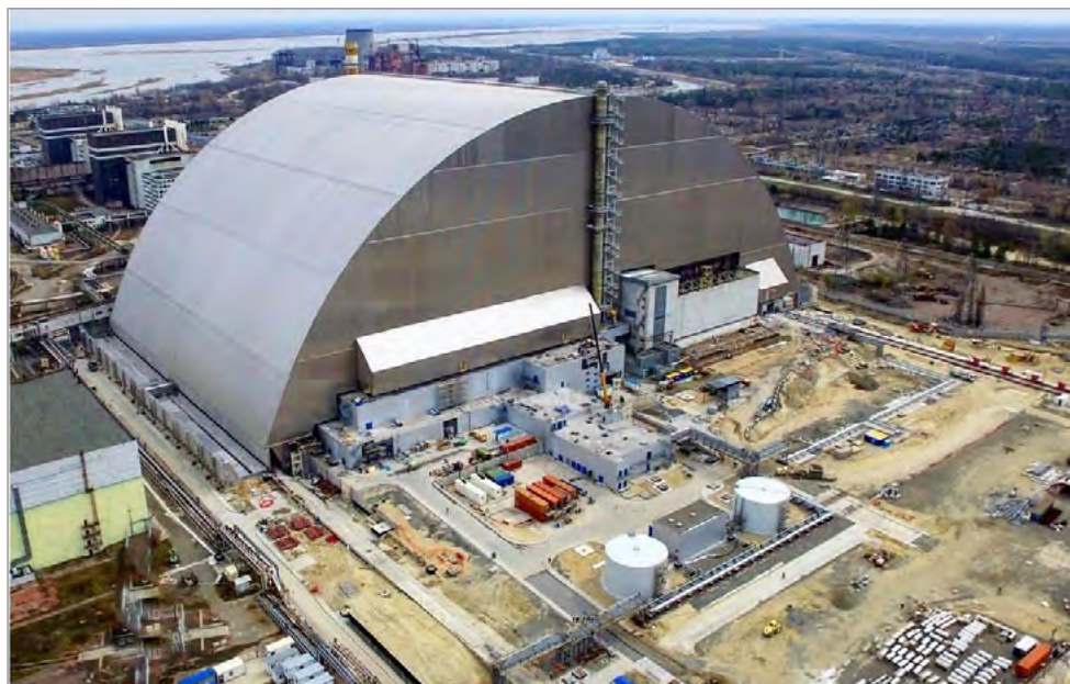
Рис. 36. НБК, закрывший объект «Укрытие»
