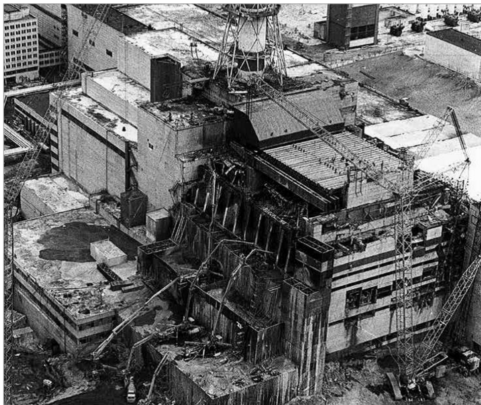
Рис. 14. Строительство «Укрытия»
