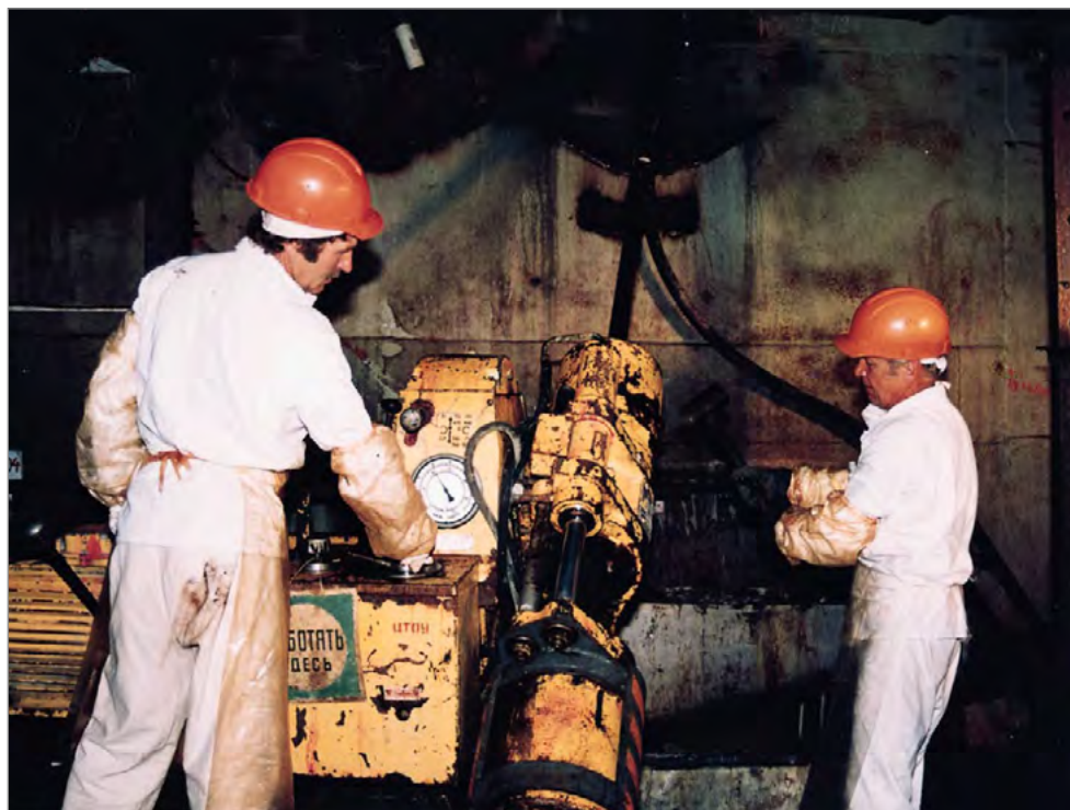
Рис. 21. «Укрытие». Подготовка бурового станка к работе, 1988 год
