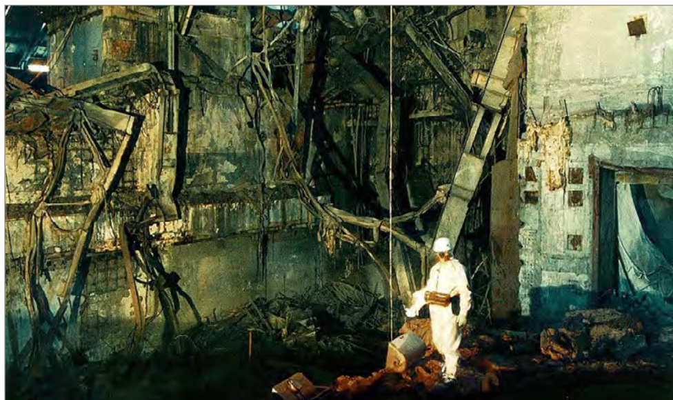
Рис. 26. В Центральном зале 4-го блока. Свет проходит сквозь многочисленные щели
