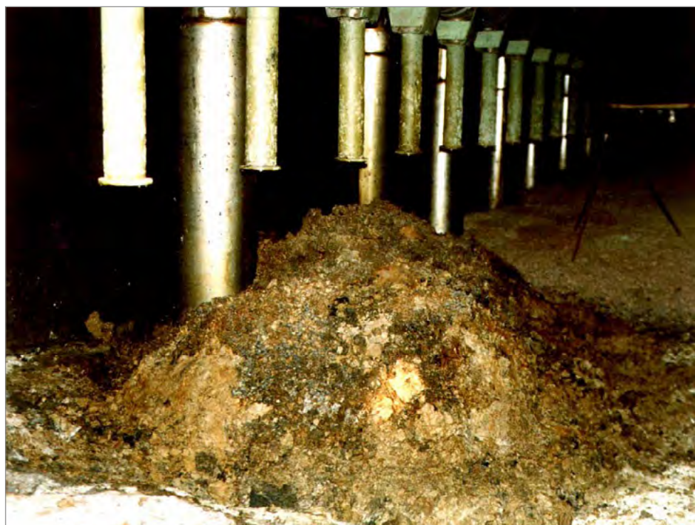
Рис. 8. Куча застывшей лавы на первом этаже бассейна-барботера
