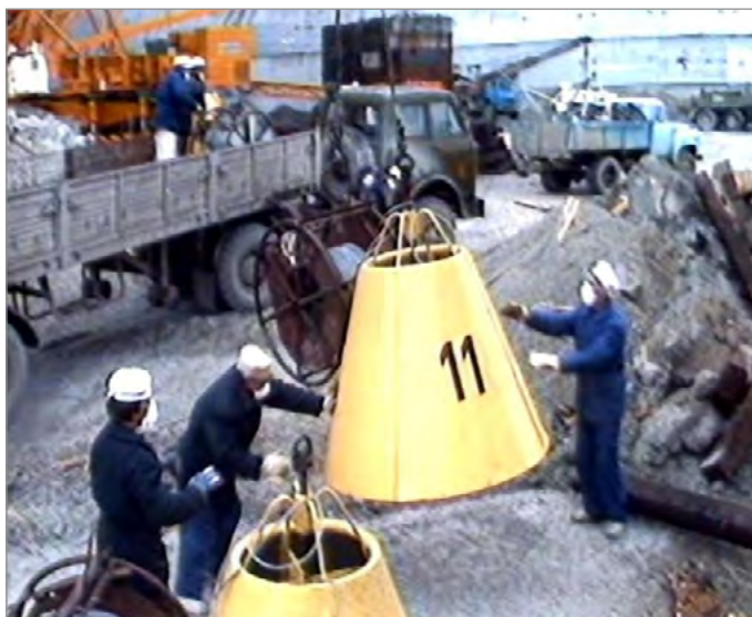
Рис. 9. Доставка Буя на площадку 4-го блока
