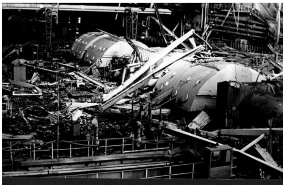
Рис. 15. Машинный зал 4-го блока после аварии
