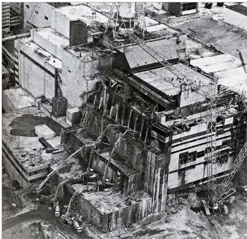
Рис. 11. Строительство «Укрытия»
