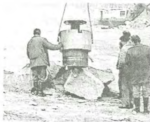
Рис. 2. Раскалывание негабарита при помощи установки “Бутобой”
