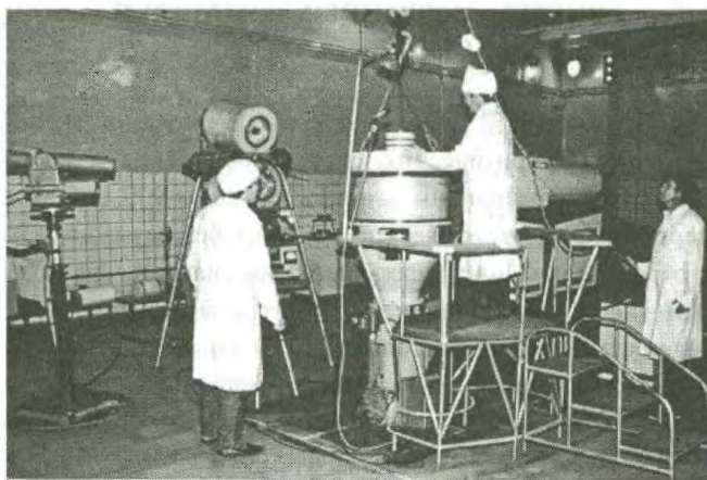
Рис. 5. Сборка цилиндрической системы с полиэтиленовым отражателем. В центре – ответственный руководитель, осуществляющий процесс сборки системы
