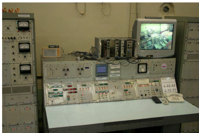
Рис. 4. Пульт управления ФКБН-2М
