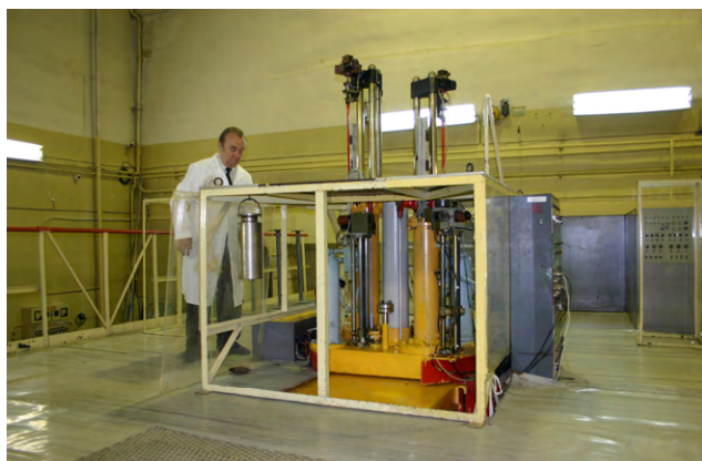
Рис. 28. Верхний зал ВВР-2М (крышка блока биологической защиты, ББЗ)
