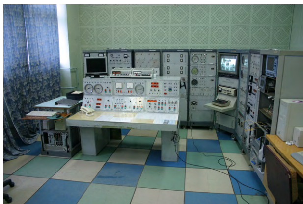
Рис. 17. Пульт управления ИЯР БР-1М
