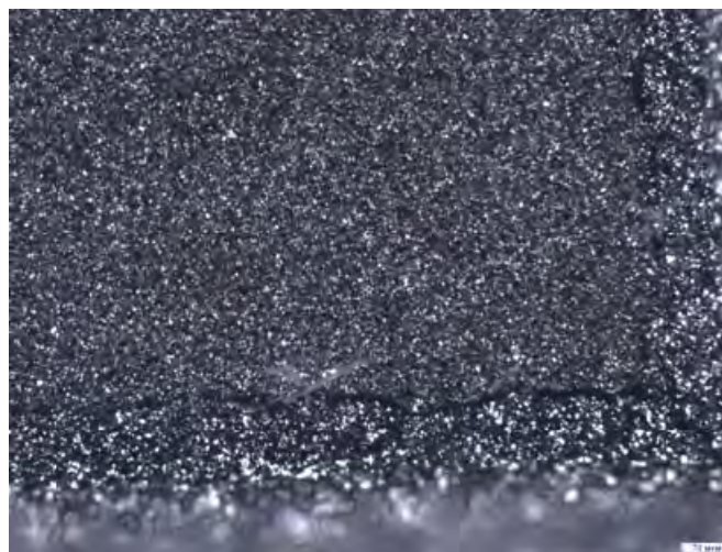
Рис. 15. Внешний вид дефекта трещины
